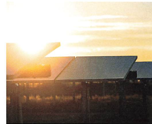
The 50-MW Titan Solar Energy Center in Colorado.
